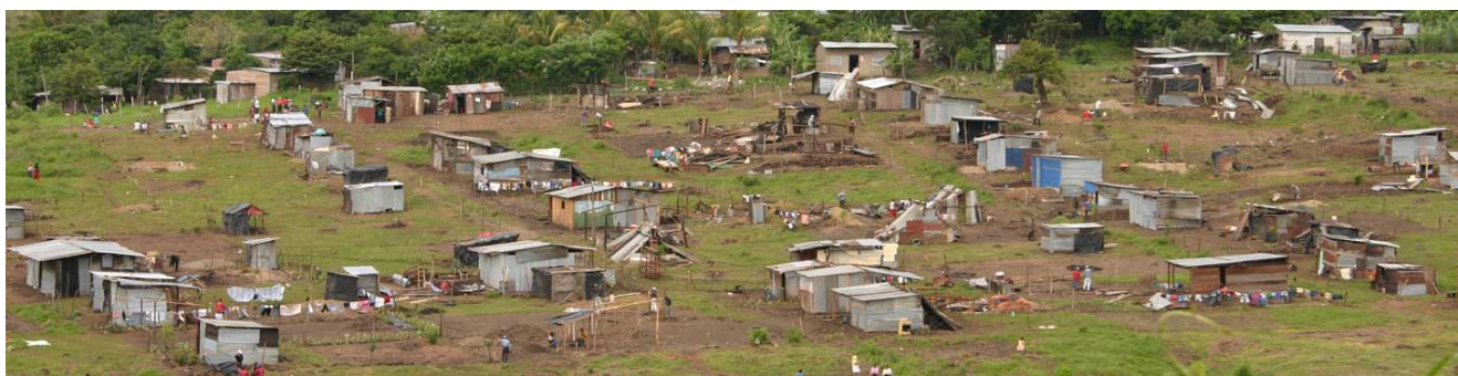
Le quartier du Nuevo Amanecer en construction
